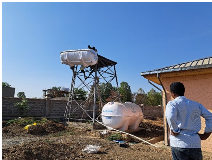
Mounting of water réservoirs on the new MRC @IOM Ethiopia 2024
